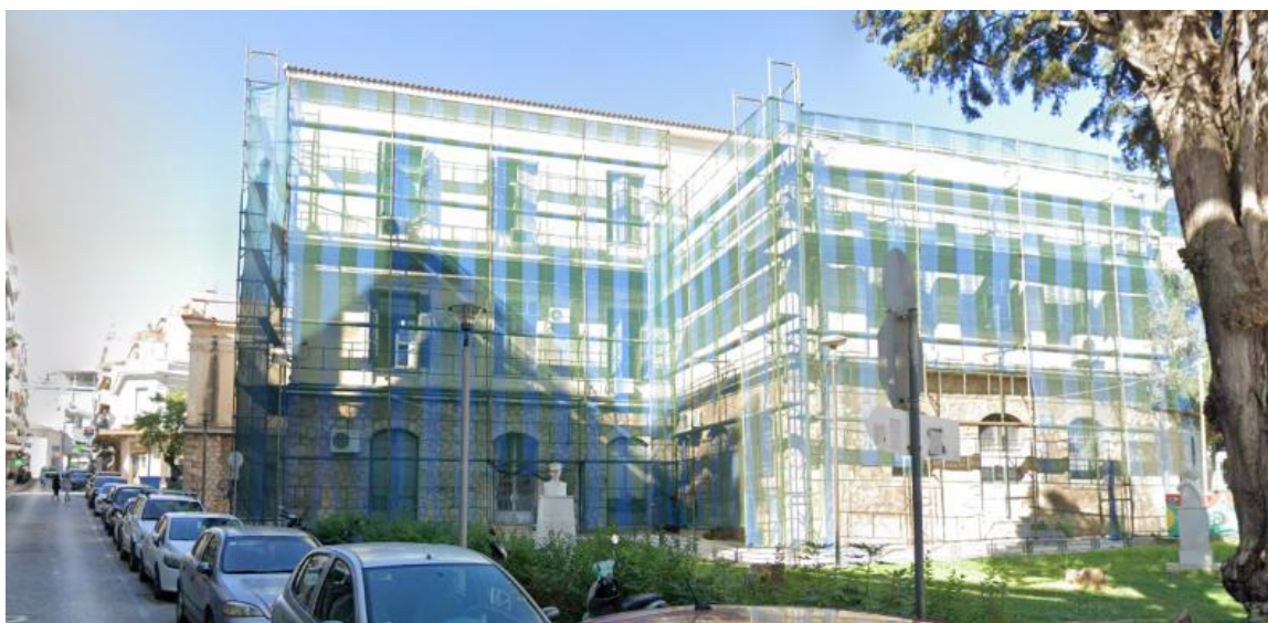
ΑΝΑΤΟΛΙΚΗ ΟΨΗ ΚΤΙΡΙΟΥ ΑΠΟ ΤΗ ΣΥΜΒΟΛΗ ΤΩΝ ΟΔΩΝ ΧΑΝΤΖΟΠΟΥΛΟΥ & ΛΕΩΝΙΔΟΥ- Λήψη από «showmystreet»
