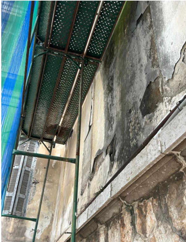
Φωτογραφία 1: αποφλοίωση σαθρού επιχρίσματος
