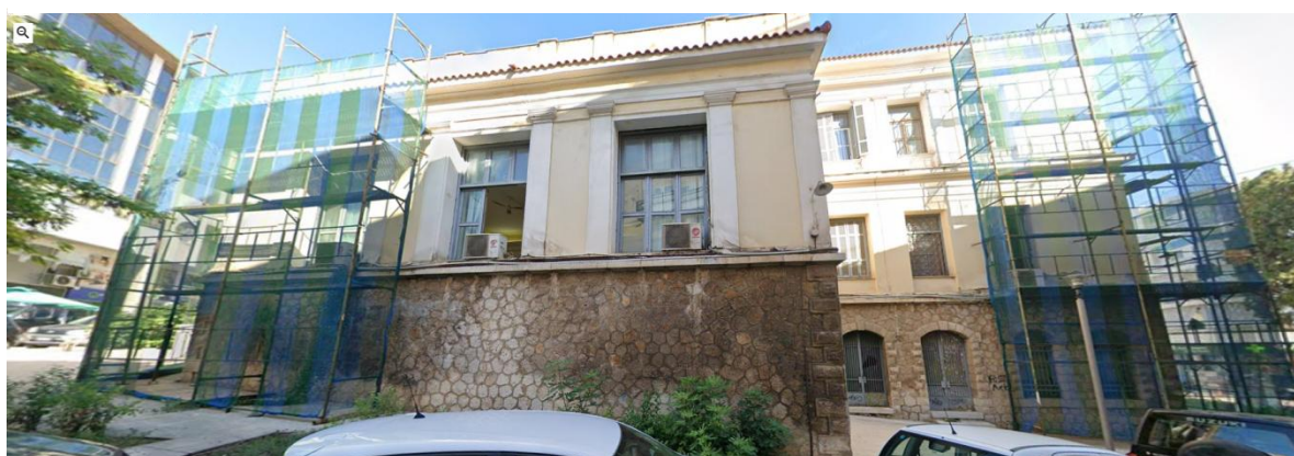
Α' ΝΟΤΙΑ ΟΨΗ ΚΤΙΡΙΟΥ ΑΠΟ ΤΗ ΣΥΜΒΟΛΗ ΤΗΝ ΟΔΟ ΧΑΝΤΖΟΠΟΥΛΟΥ- Λήψη από «showmystreet»
