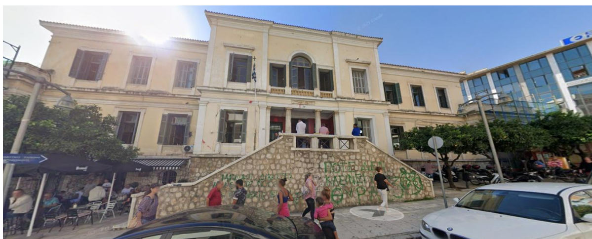
ΒΟΡΕΙΑ ΟΨΗ ΚΤΙΡΙΟΥ ΑΠΟ ΟΔΟ ΚΑΠΟΔΙΣΤΡΙΟΥ- Λήψη από «showmystreet»
