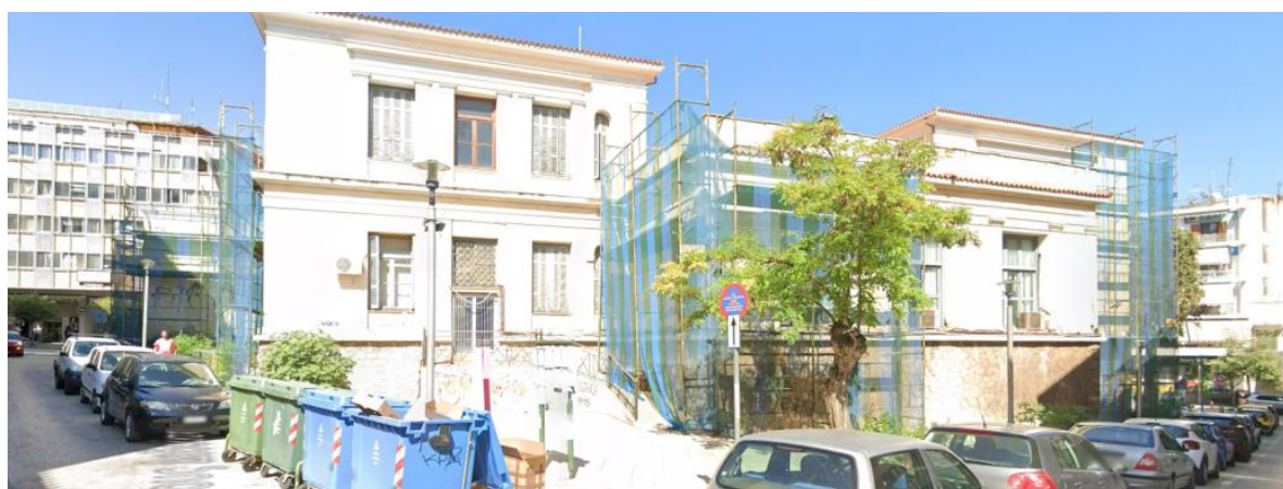
Β' ΝΟΤΙΑ ΟΨΗ ΚΤΙΡΙΟΥ ΑΠΟ ΤΗ ΣΥΜΒΟΛΗ ΤΩΝ ΟΔΩΝ ΧΑΝΤΖΟΠΟΥΛΟΥ ΛΕΩΣΘΕΝΟΥΣ- Λήψη από «showmystreet»
