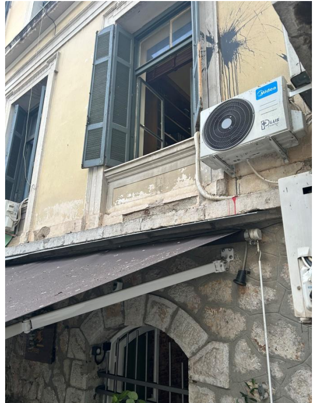
Φωτογραφία 2: αποκόλληση διακοσμητικού στοιχείου κάτωθεν παραθύρου
